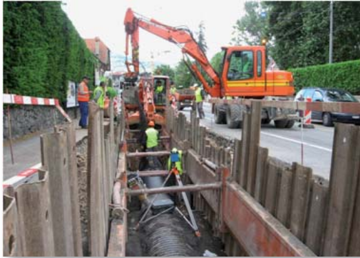
Remplacement de collecteur EC, diam. 850
