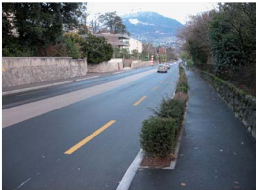
Aménagement en enrobé phono-absorbant et trottoir végétalisé
