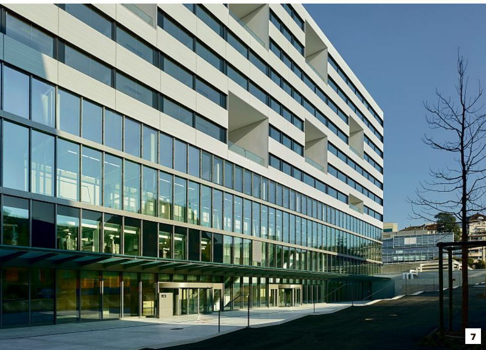
7 Marquise, entrée principale
