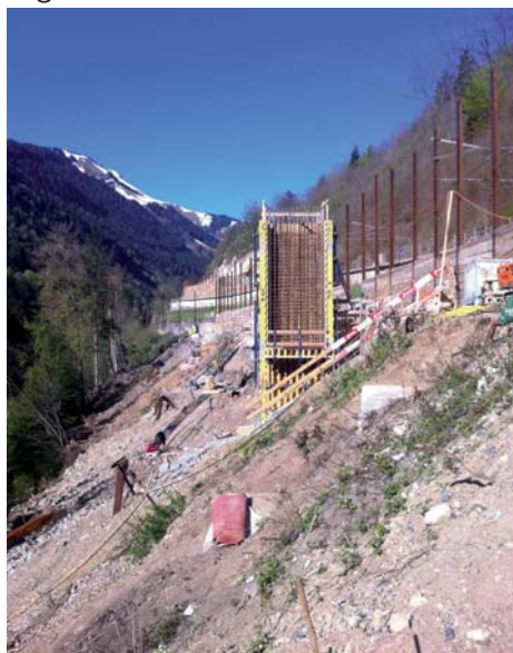
Pile à l'aval de la ligne de chemin de fer
