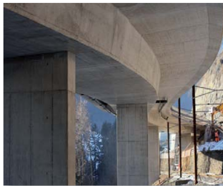
Vue du caisson du pont
