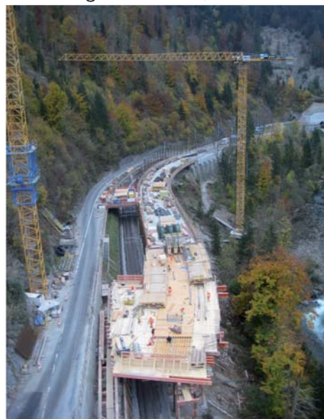
Vue d'ensemble de l'ouvrage en construction
