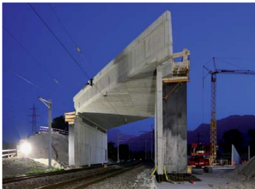
Nouveau tablier mis en place
