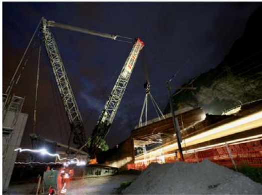
Démolition du pont existant
