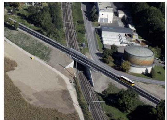
Ouvrage en service
