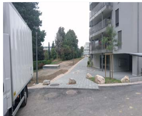
Chemin pavé avec tranchée d'infiltration
