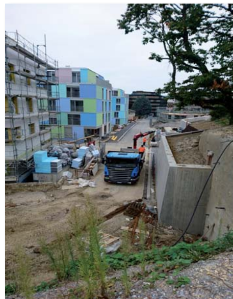
Réaménagement complet d'une route d'accès
