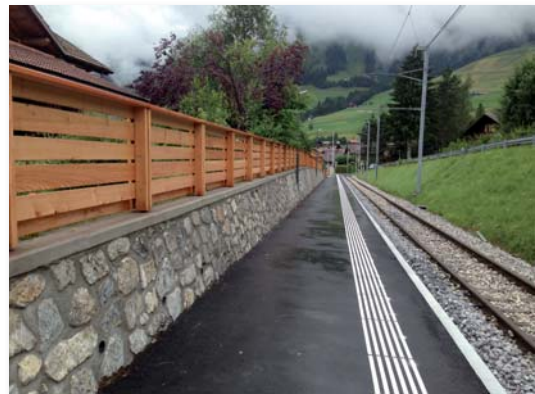
Mur de soutènement de la Halte La Palaz
