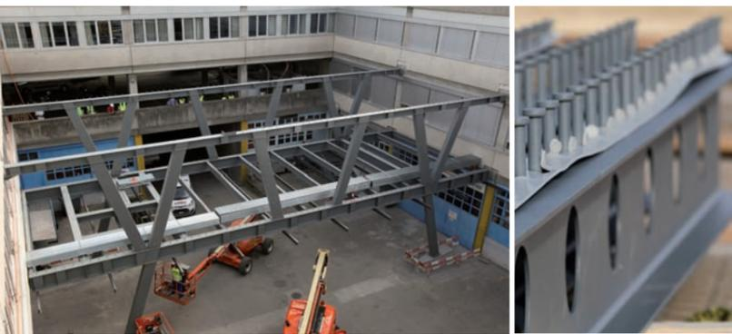
Cette structure métallique d'une largeur de 8 m et d'une portée de 23 m a été fabriquée dans les ateliers de Sottas SA à Bulle. Elle est composée de piliers en tubes métalliques rectangulaires et de 3 niveaux de plancher mixte. Elle a été transportée par convois spéciaux et montée de nuit pour minimiser la gêne des usagers de la cour. Le passage des camions et véhicules légers est toujours possible dans la cour, entre les poteaux.
