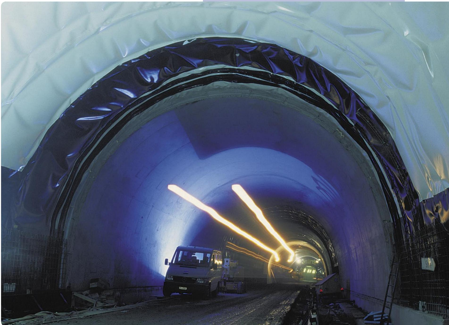
En haut: réfection du pont sur la « Baye de Montreux ». Ci-dessus: nouvelle voûte et pose de l'étanchéité.
